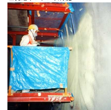
■発泡ウレタン吹付施工
