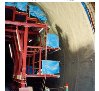
■フィップ防火コート吹付施工
