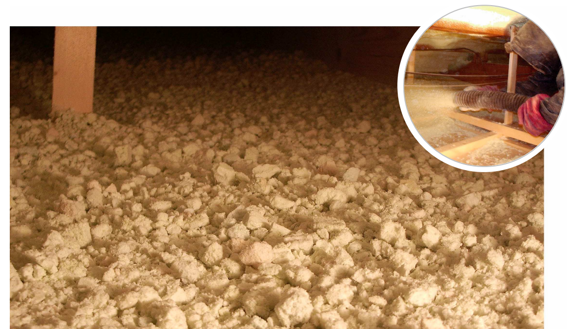
発泡ウレタンブローイング施工状況
