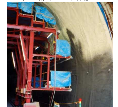
■フィップ防火コート吹付施工
