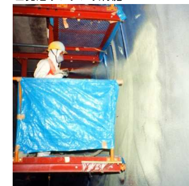
■発泡ウレタン吹付施工
